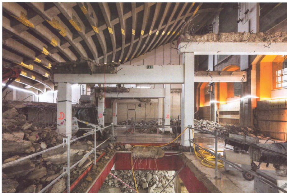
Hall historique en cours de déconstruction - Photo © Patrick Tourneboeuf / Tendence floue
