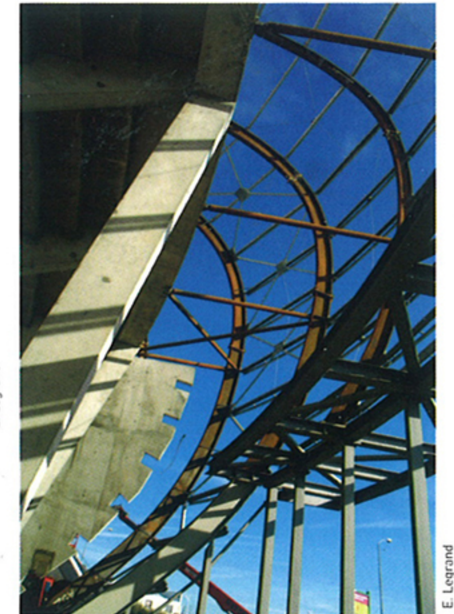
Détail des arcs cintrés.
