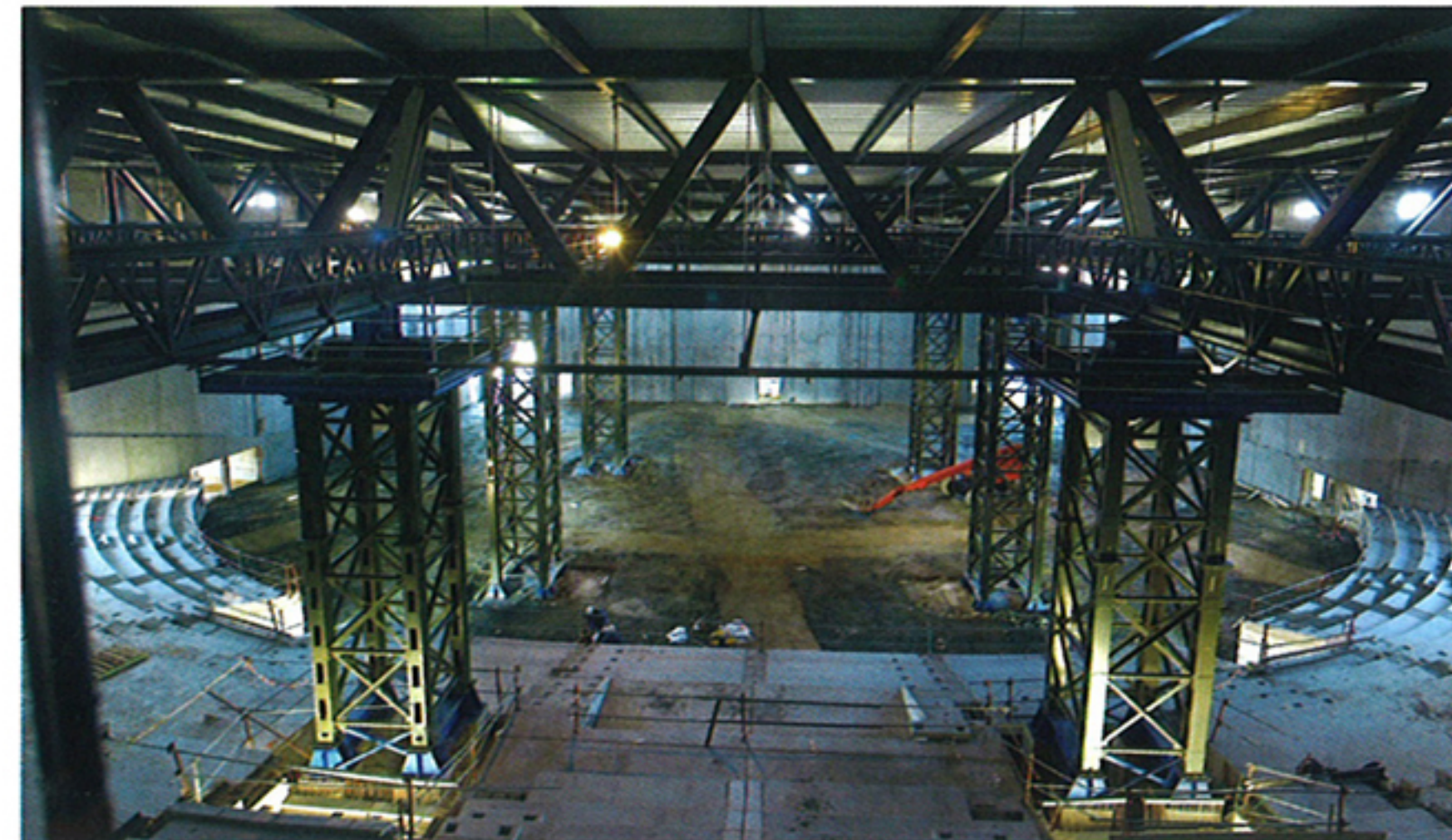
Montage des poutres maitresses.
